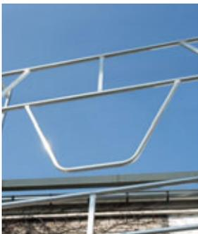
Mit dem optionalen Sicherheitsaufbau ist der Auf- und Abbau über die einzelnen Plattformen problemlos möglich. Das vorlaufende Geländer bietet beim Auf- und Abbau in jeder Etage zusätzliche Sicherheit.
