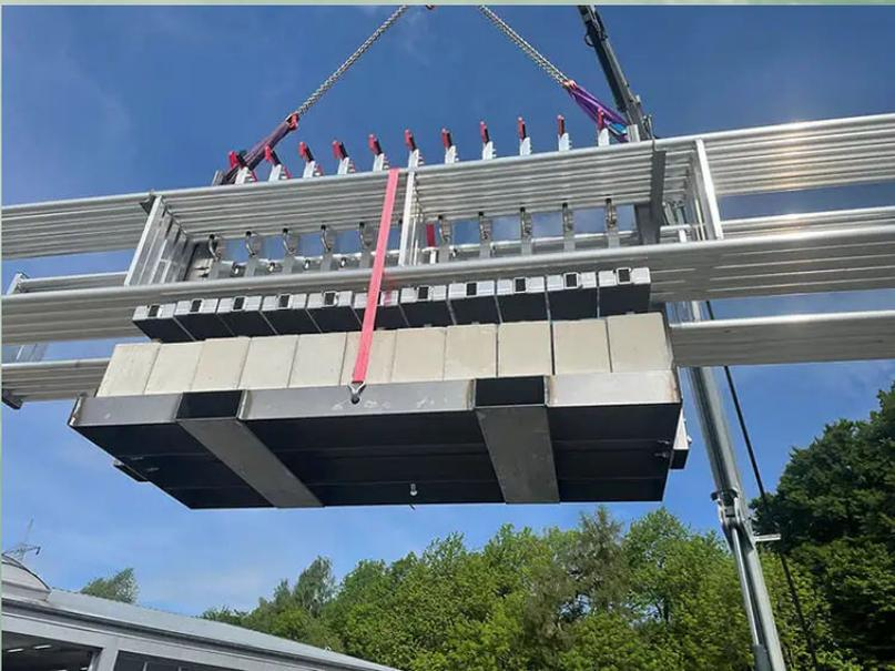
Das RSS Roof Flachdachsystem entspricht den Sicherheitsanforderungen gemäß der europäischen Norm EN13374 + A1 2019 (Klasse A).
