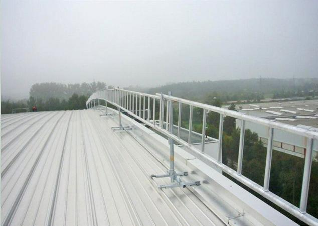
Ein Seitenschutzsystem der Klasse A nach DIN EN 13374 für alle Kalzip, Wellblech- und Trapezblechdächer bis 10° Dachneigung. Ideal als Absturzschutz bei der Montage von Solar und Photovoltaikanlagen.
