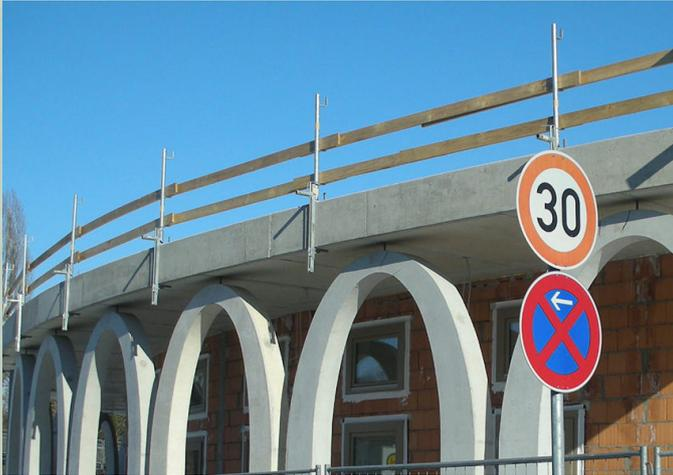
**Multi steht bei dieser Zwinge für die Mehrfachfunktion. Einsatz als Geländer-, Brüstungs- und auch als Schalzwinge möglich.**
